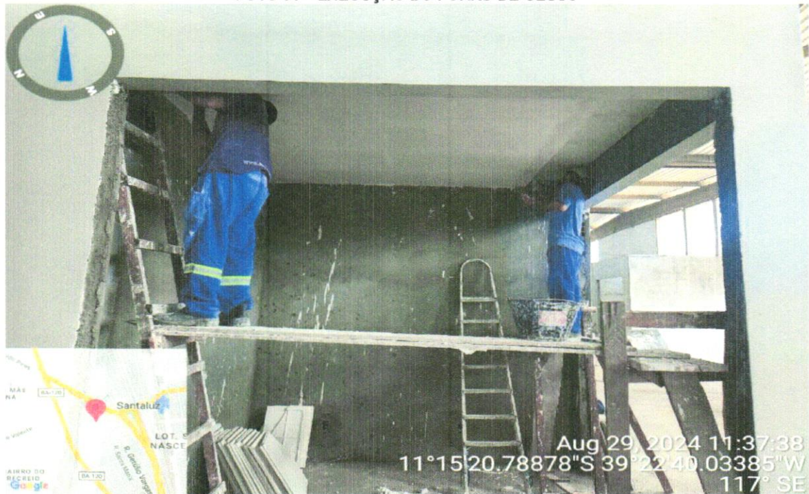
FOTO 02 – EXECUÇÃO DO FORRO DE GESSO
