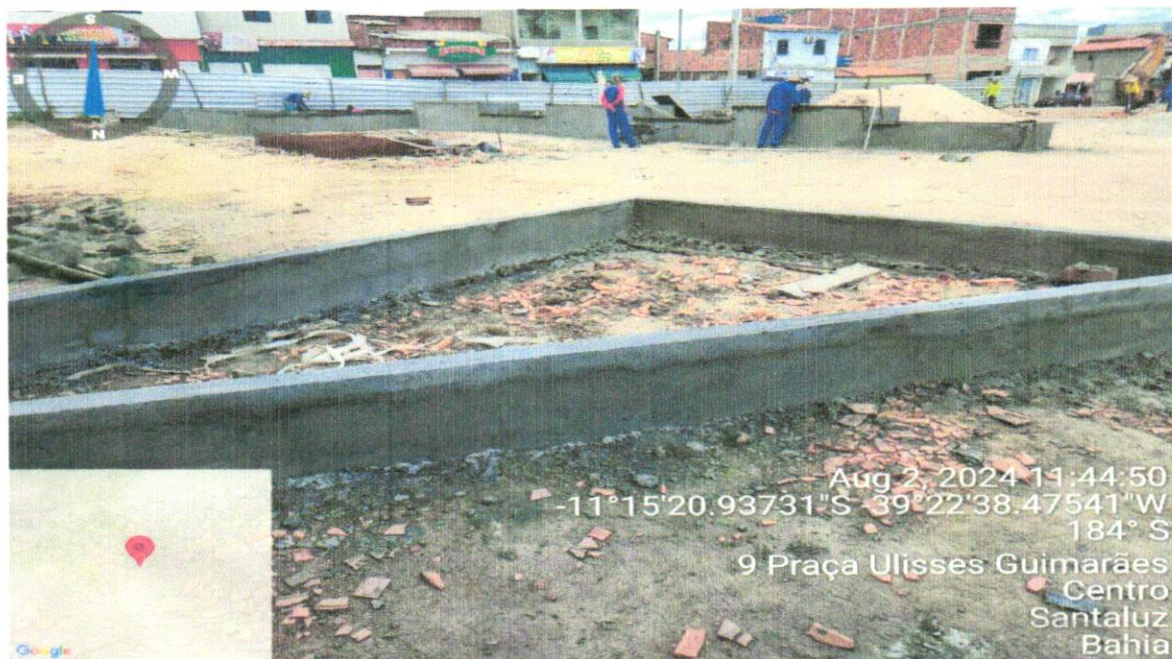
FOTO 30 – EXECUÇÃO DA ALVENARIA DO ESTACIONAMNETO
