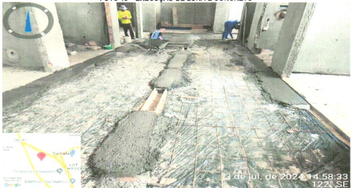
FOTO 18 – EXECUÇÃO DE LONA E CONCRETO
