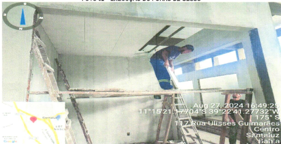
FOTO 02 – EXECUÇÃO DO FORRO DE GESSO
