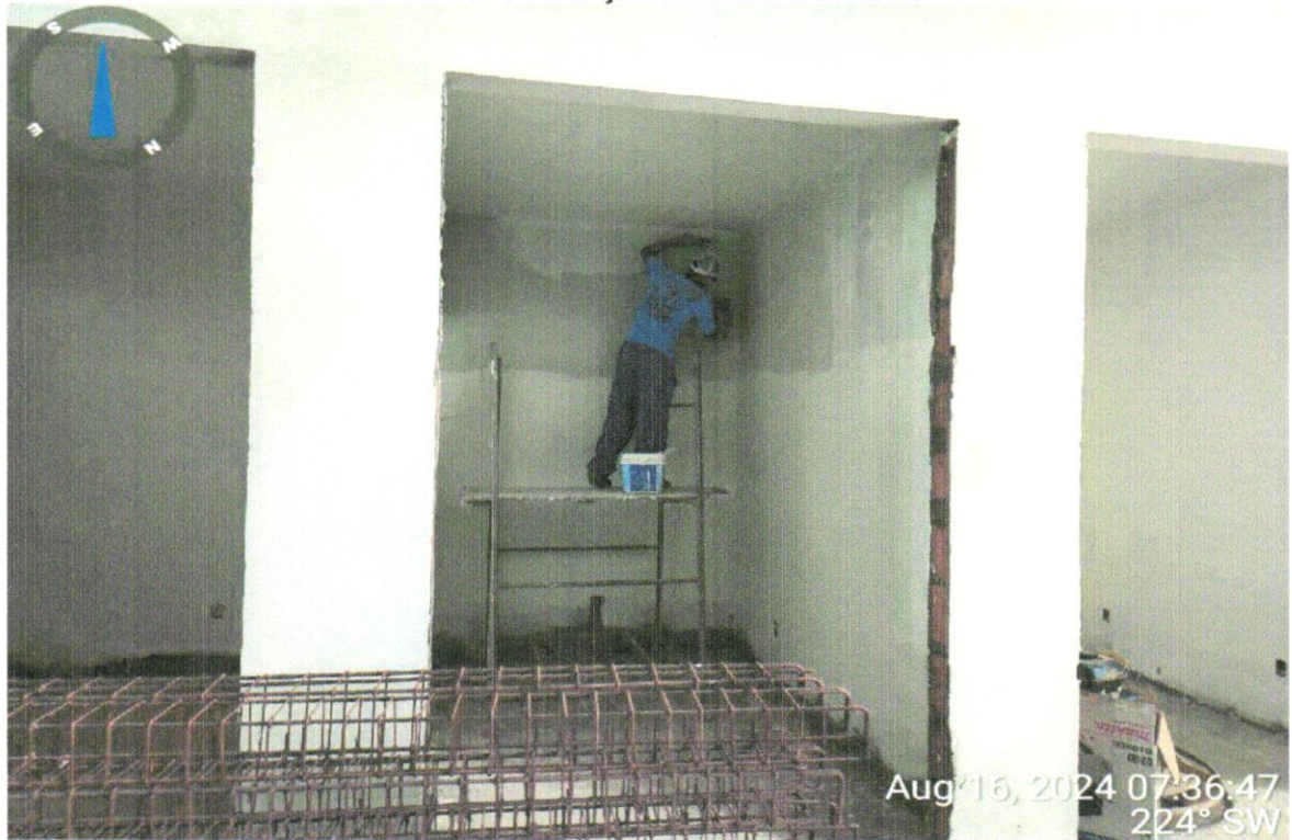
FOTO 08 – APLICAÇÃO DE MASSA ACRÍLICA
