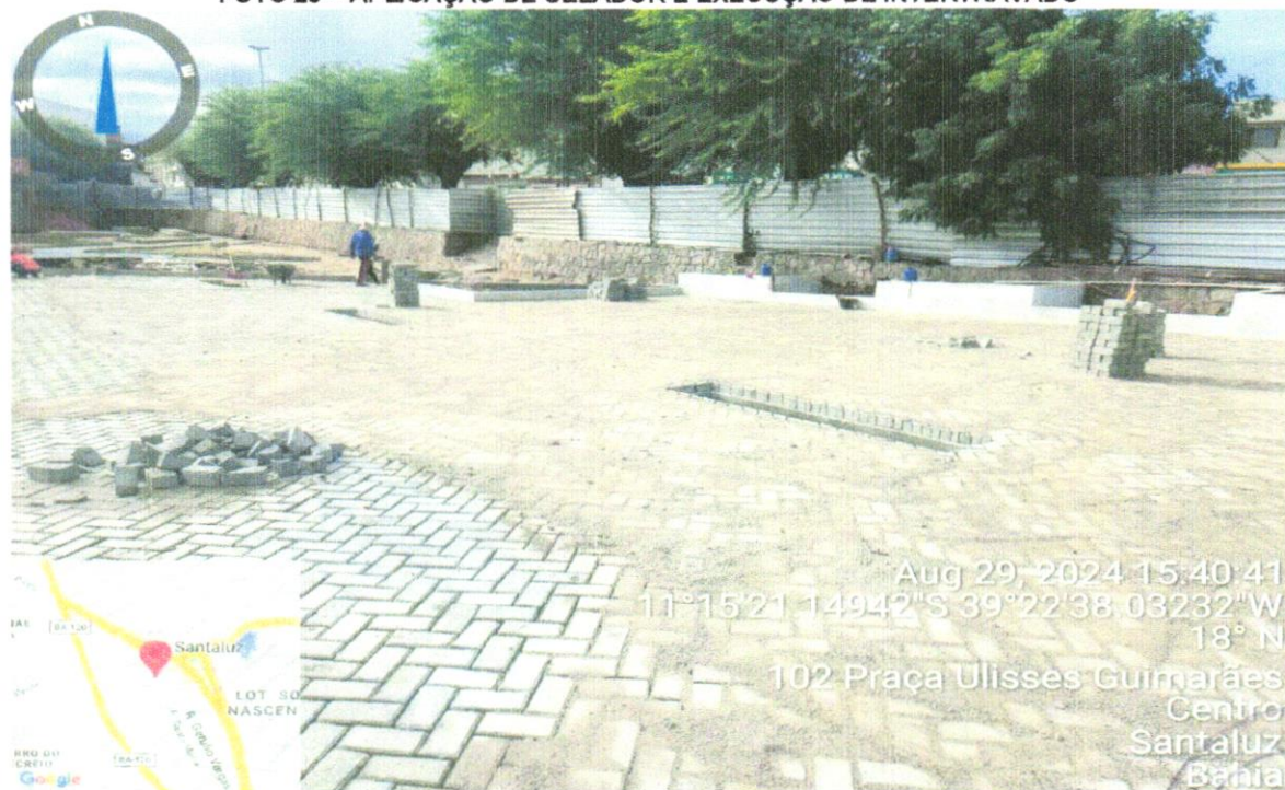
FOTO 28 – APLICAÇÃO DE SELADOR E EXECUÇÃO DE INTERTRAVADO
